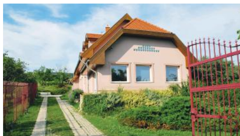
Családi ház padló és radiátorfűtéssel
