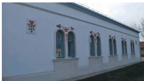
Tulipánkert óvoda radiátorfűtés
