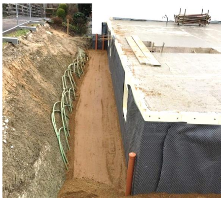
gyűrűs kollektor fektetése 6-9W/m
